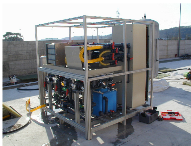
EDR fase di installazione
