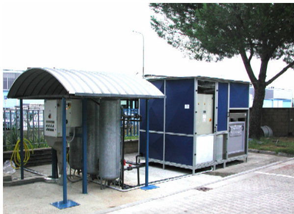
CarWash box con filtri a sabbia esterni
